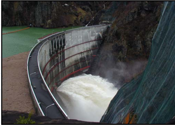
豊平峡ダムの貯水位・放流状況 (2000/5/13)
