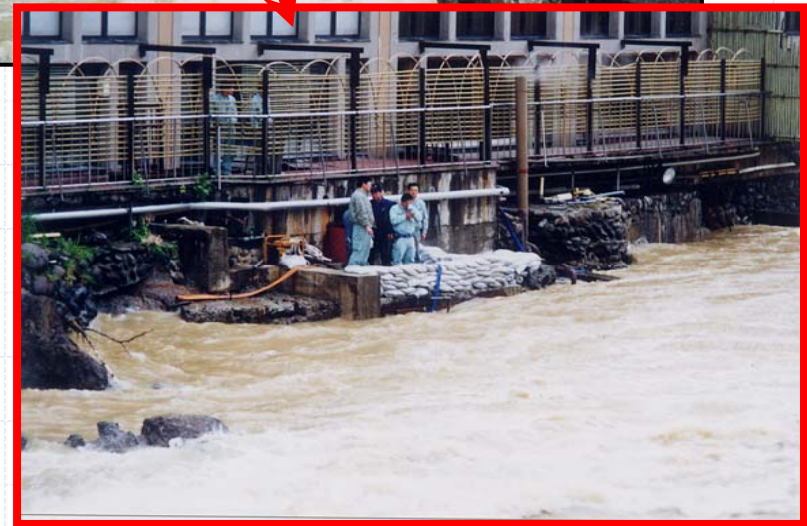
下流の定山溪温泉街の状況 (2000/5/13)
