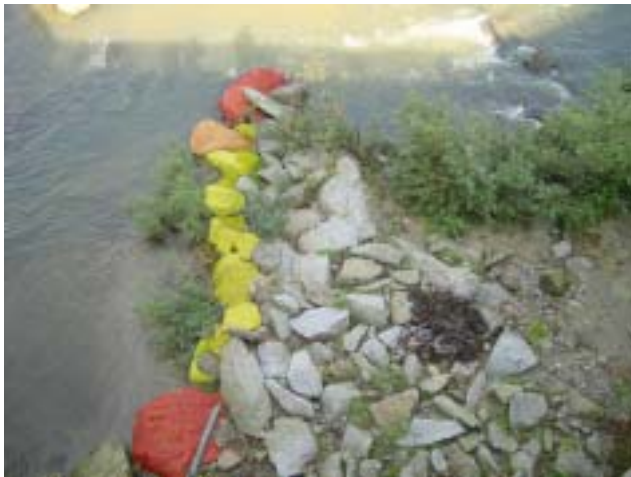
写真 16 写真 15 の主要な石に色を付けたもの 赤色の石：力石(ちからいし) 黄色の石：アーチ状に配置されている 札ヅ 色の石：楔石(くさびいし)
