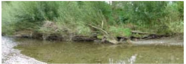
一番上：図-2 別の事例 - ワイカナエ川 - の航空写真に書き込まれた概略設計図(G&E.Williams Consultants Ltd 「Waikanae 川 SH1 ~ Mapple レーン区間改修計画書」199?) 下の左：写真4 ワイカナエ川の石積み水制 下の右：写真5 柳の倒木をワイヤーで固定した護岸
