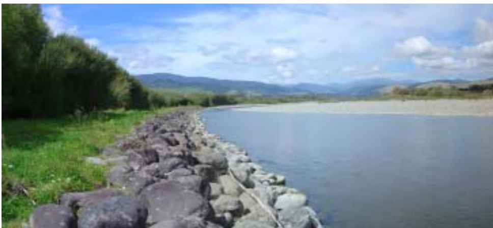
写真 3 写真 2 の川の一部で使われている捨石 (Rip-rap) 護岸
