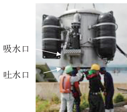
写真-2.2.4.12 溶存酸素供給装置外觀
