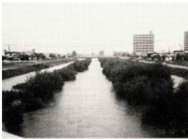
写真-1 河畔林の繁茂による流下能力の低下
